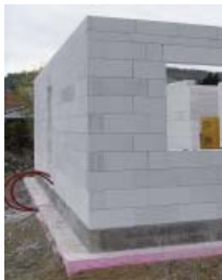
Obr. 6 Díky vysoké únosnosti a nenasákavosti je extrudovaný polystyren ideální pro použití například při založení betonové desky na izolaci. Tím je eliminován tepelný most v patě zdi a tepelná izolace probíhá kolem domu bez přerušení.
