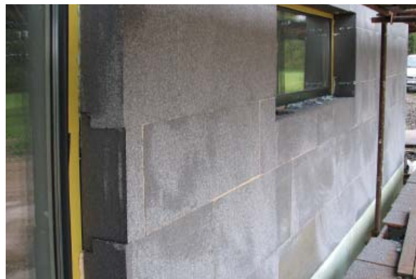
Obr. 3 Při montáži ETICS na bázi EPS lze na soudržný a rovný povrch do výšky 8 m celoplošně lepit bez kotvení. Na obrázku 30 cm EPS s přidavkem grafitu celoplošně lepeno na vápenopískové cihly tl. 175 mm. (pozn ostatní obrázky je potřeba přečíslovat)
