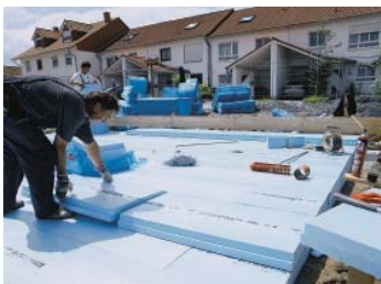
Obr. 6 Díky vysoké únosnosti a nenasákavosti je extrudovaný polystyren ideální pro použití například při založení betonové desky na izolaci. Tím je eliminován tepelný most v patě zdi a tepelná izolace probíhá kolem domu bez přerušení.
