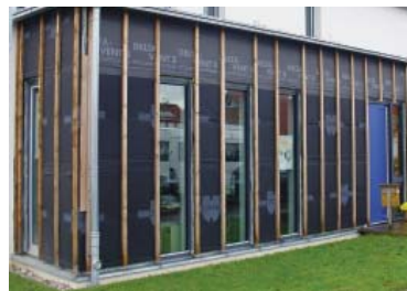
Obr. 2 Provětrávaná fasáda u novostavby před namontováním fasádního obkladu. Svíslé laťování před pojistnou hydroizolací tvoří vzduchovou mezeru.
