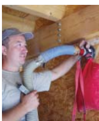
Obr. 8 Celulóza se nejčastěji aplikuje volným foukáním nebo pod tlakem do uzavřených dutin. Výhodou je cena a rychlost aplikace.
