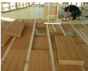
Obr. 9 Izolace z přírodních materiálů mají obdobné využití jako běžné izolace - vkládané do roštu nebo o vyšší objemové hmotnosti jako fasádní izolace s tenkovrstvým omítkovým systémem.
